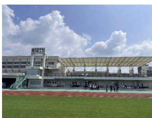
メインスタンド (金武町陸上競技場)
