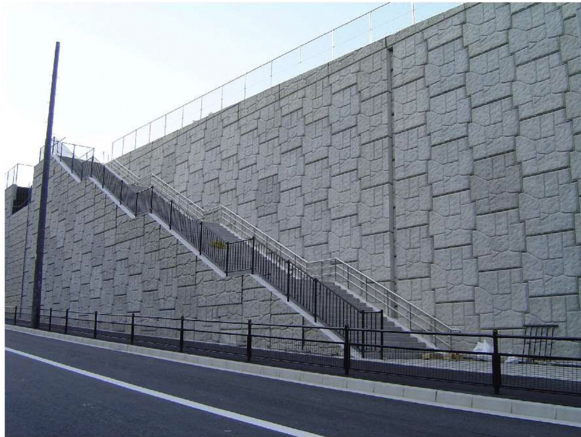
補強土壁（石積風）のイメージ
