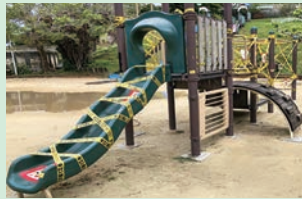
▲使用禁止となっている市内公園の遊具
