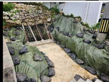
現場養生作業後の様子
