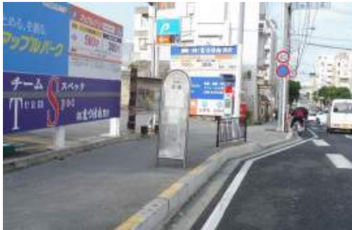
写真 3-3-1 道路に対して直角方向のバス停設置例（那覇市：壺屋バス停）
