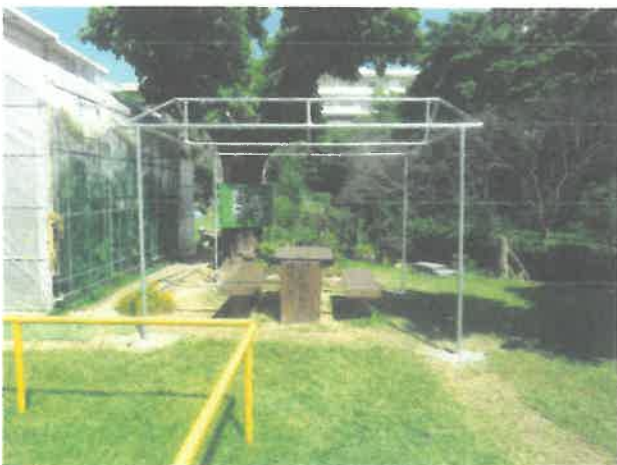
（パーゴラパイプ組み立て状況）
