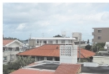
奇棟屋根が手前の高架タンクで分断されています。
