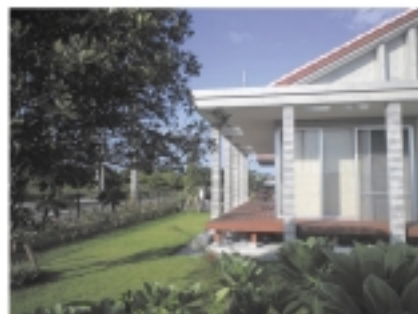
伝統的な構成を残した近代的な建築
