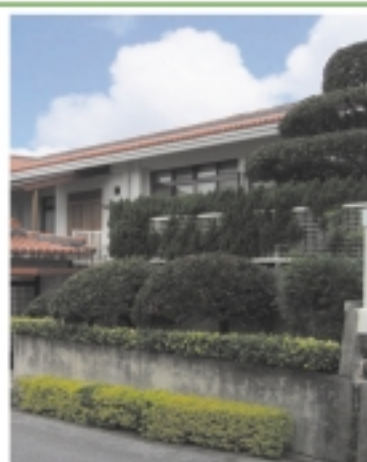
地盤面の高さを段を設け緩和している。
