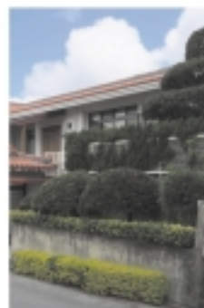
擁壁を2段に分節化を図ることで、心地良いスケールとなっています。
