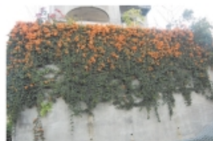
擁壁を緑化することで緑の環境を提供しています。
