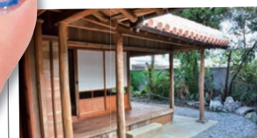
2017年に7年間の修復工事を終えた 津嘉山酒造所施設
