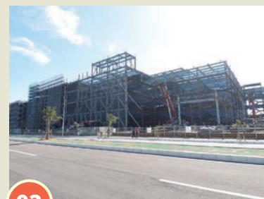
03 サンエーパルコ(建設中)
