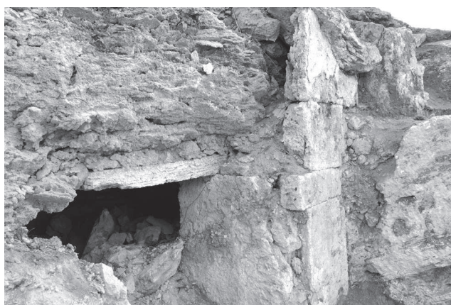
013 号墓正面石組状況
