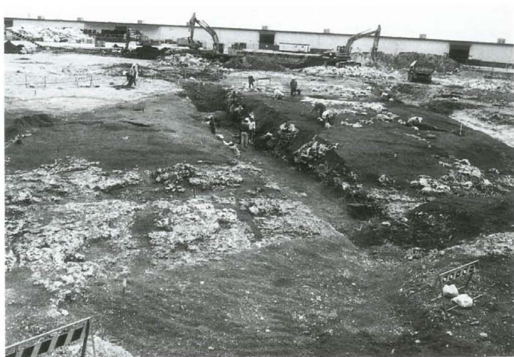
図版 14 B地区発掘作業状況
