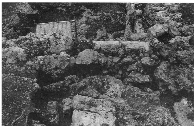
▲庇の裏込め（屋根上から）
