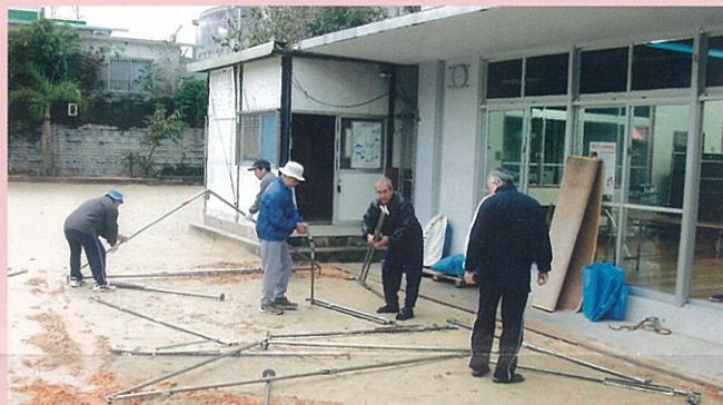
水はけ後テント設営に力を合わせる
