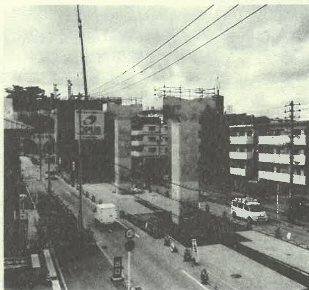
市内での工事現場、後方は前田トンネル
