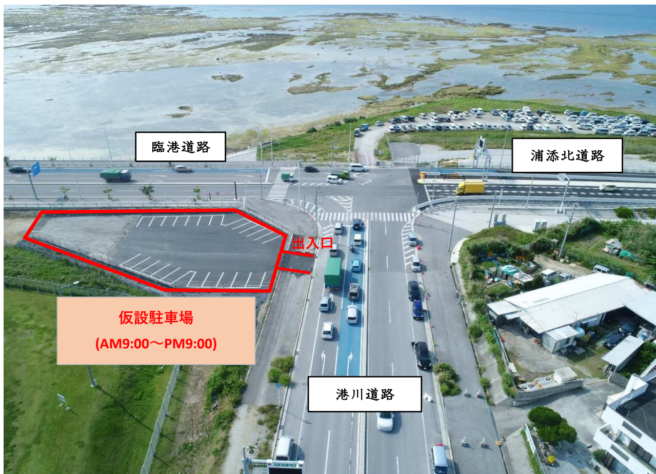
仮設駐車場(空撮)
