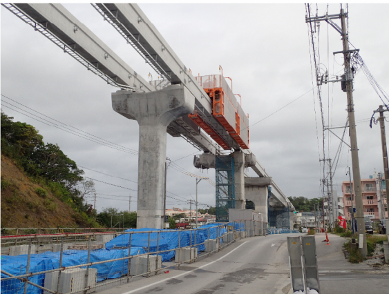
起点側モノレール架設状況 (H30 年 3 月撮影)
