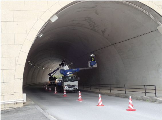
上り線点検状況 (H30 年 3 月撮影)
