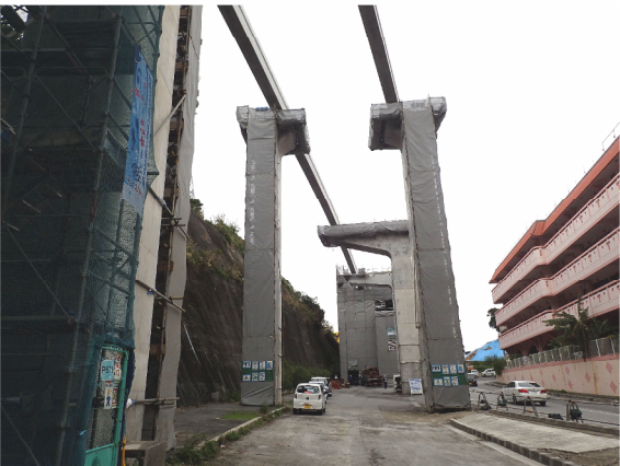
終点側モノレール架設状況 (H30 年 3 月撮影)
