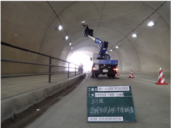
上り線点検状況 (H30 年 3 月撮影)
