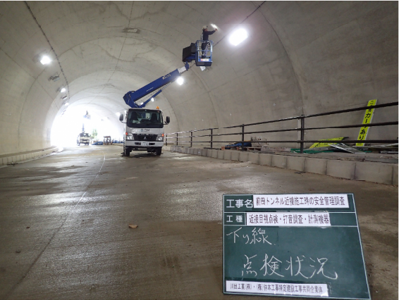
下り線点検状況 (H30 年 3 月撮影)
