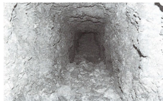
坑木跡の残る壕内
