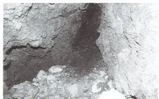
壕内の落盤跡
