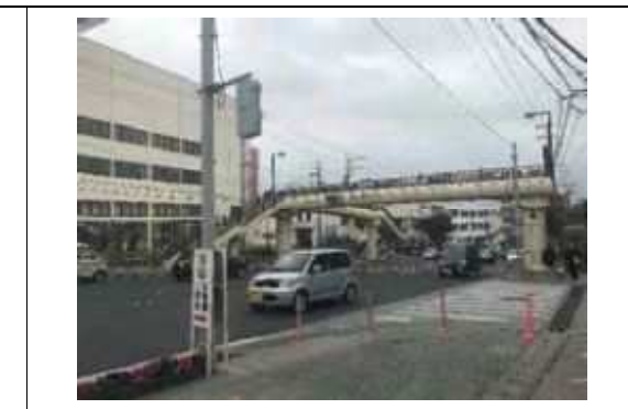
写真⑧. 県道 241 号線に架かる歩道橋
