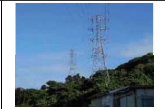
写真⑩. 小学校区を横断する送電鉄塔
