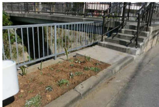
切り株撤去後の整地
