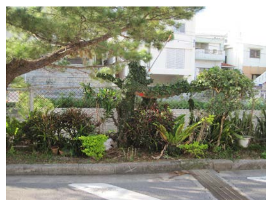
枯れた大きな木を撤去
