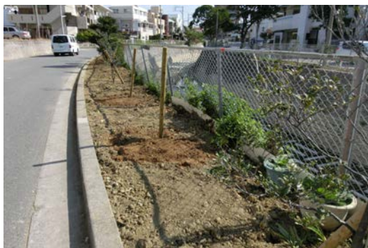
除草後の整地
