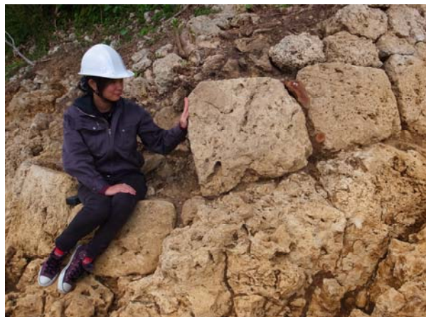
写真38 c. 城壁隅の巨大切石
