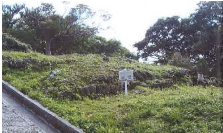
写真 23 復元整備前の城壁（城外より撮影）
