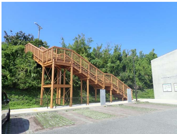
写真19 階段(南エントランス管理事務所横)
