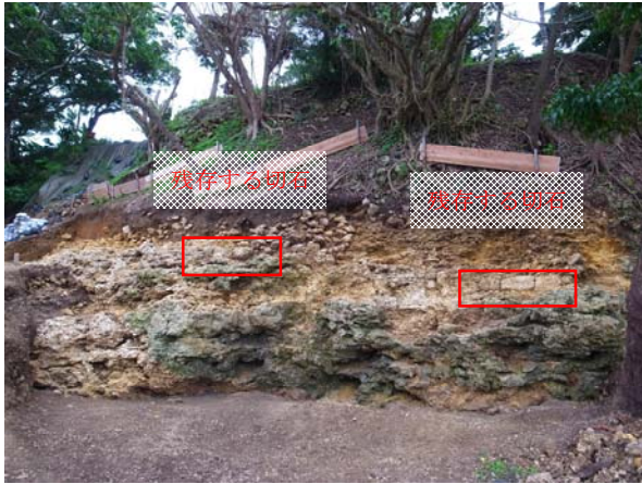
写真 45 基盤岩上に確認された切石
