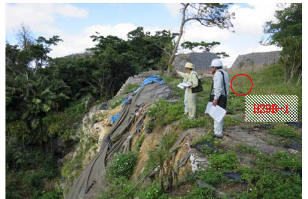
写真 67 ボーリング孔 H29B-1 (遠景)
