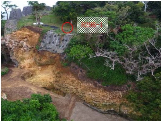
写真 70 H29B-1 地点の地質層序全景写真
