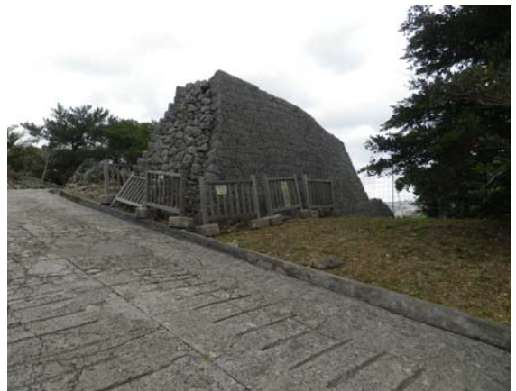
写真 25 復元整備した城壁（城外より撮影）
