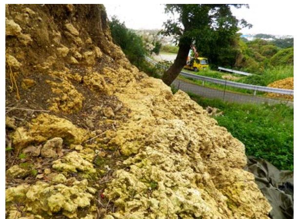
写真 48 平らにはつられた岩盤部
