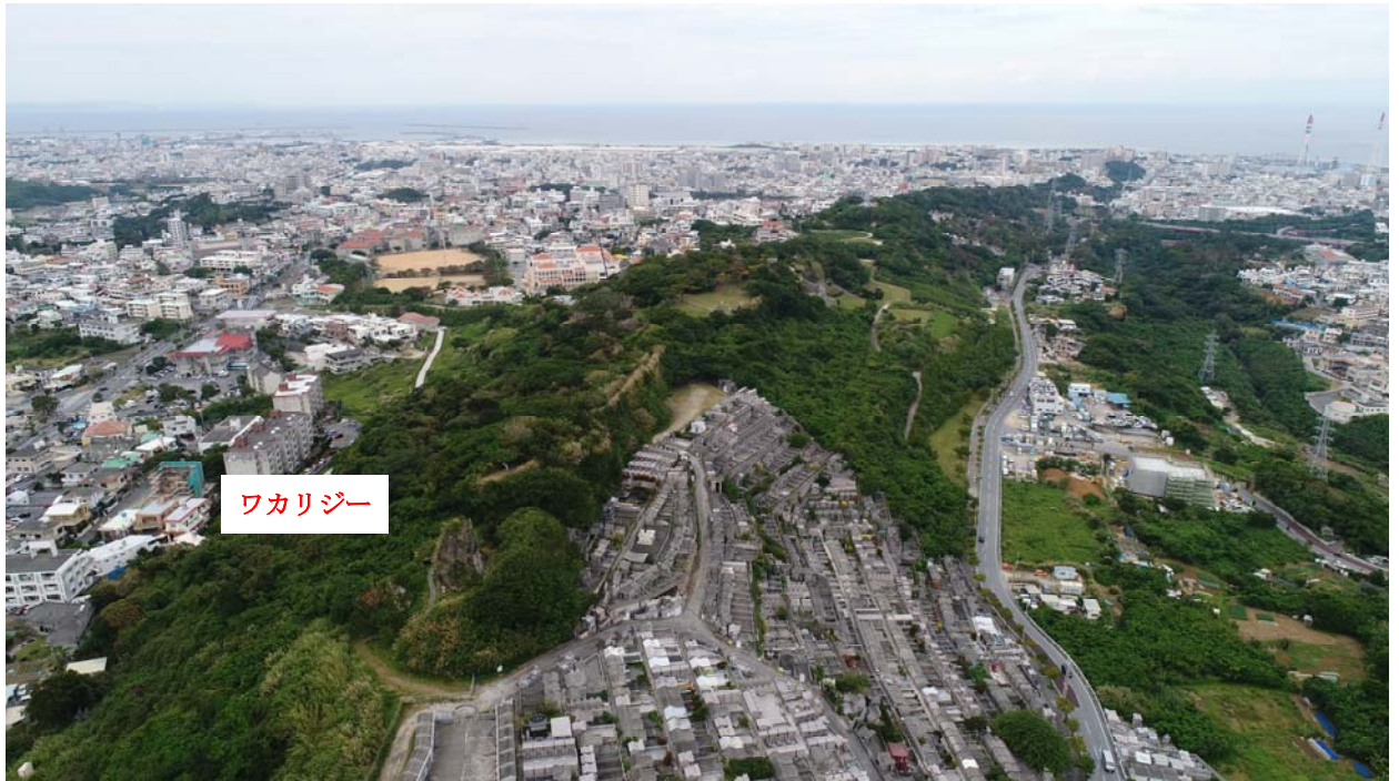
浦添城跡全景空撮写真（南東上空から）
