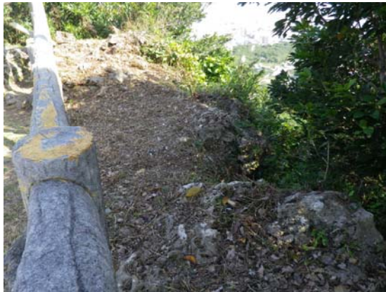
写真 81 安全柵背後の現況
