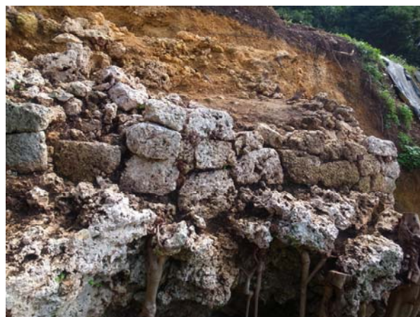
写真 51 確認された岩盤上の城壁遺構
