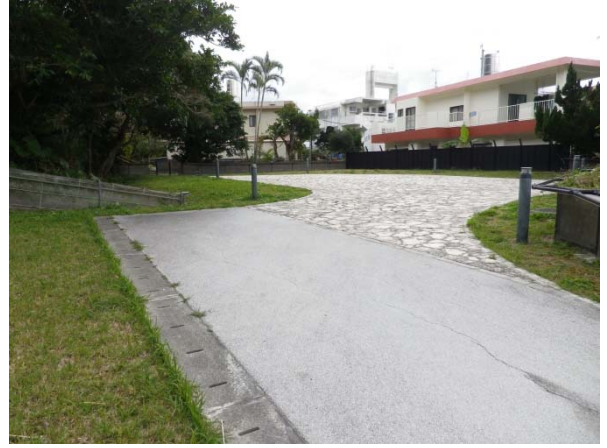
写真10 2号園路終点付近（近景）
