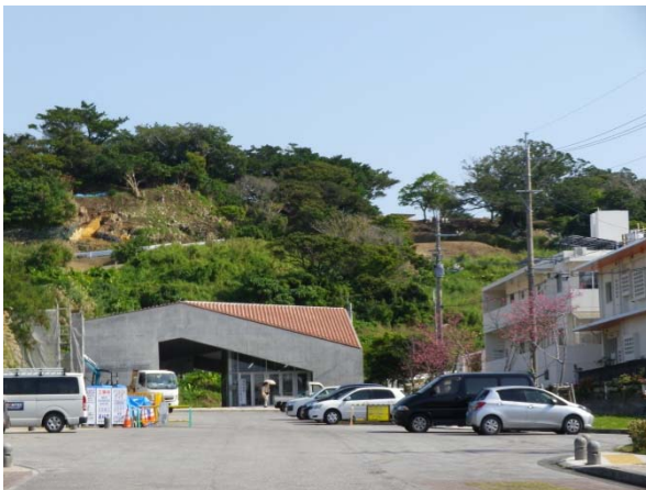
写真 16 南エントランス管理事務所（全景）
