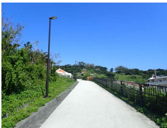
写真21 照明灯(1号園路)
