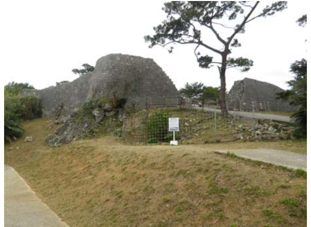
写真 29 復元整備した城壁（城外より撮影）
