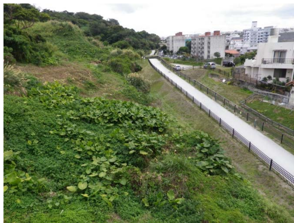
写真8 2号園路整備後（南側斜面と市営団地）
