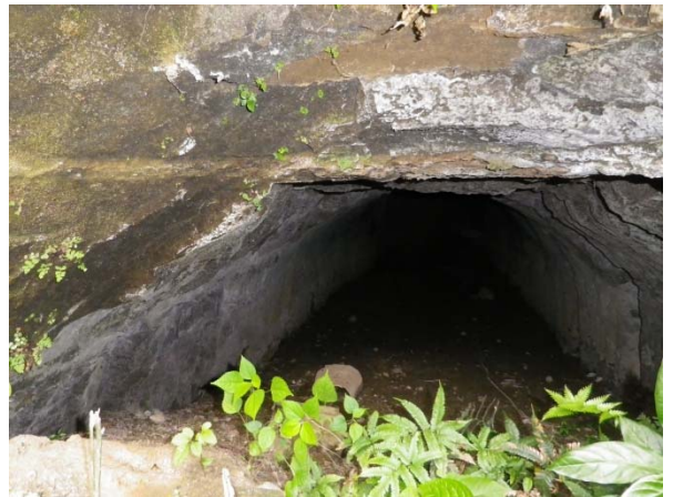
写真12 缶詰壕内部の現況
