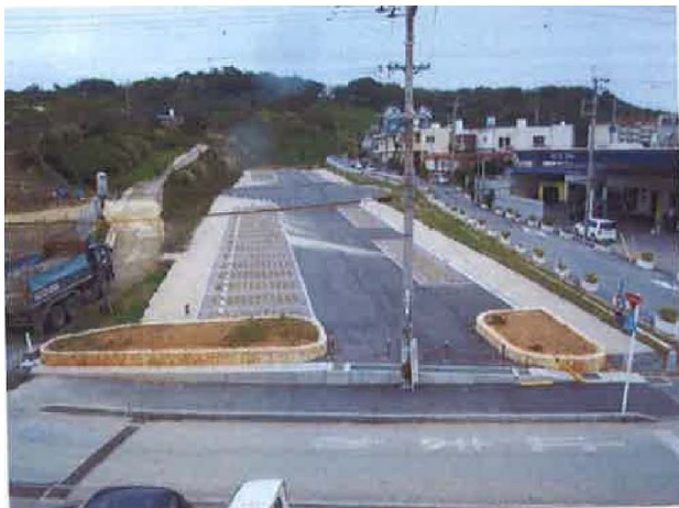
写真4 整備中の1号園路（写真左側）
