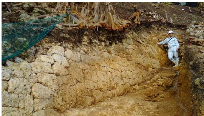
写真 59 残存する最大 10 段、高さ 2 m の石積み
