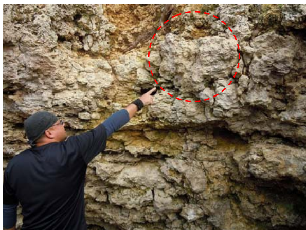
写真 60 表面の風化や亀裂、浮石
