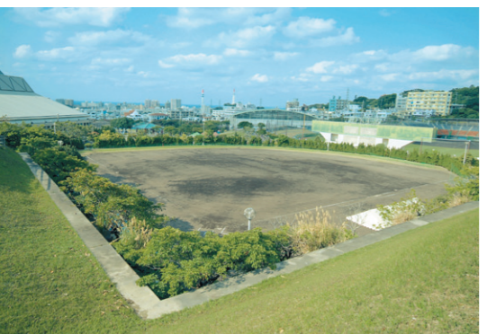
多目的屋外運動場 市民球場のサブグラウンドなど多目的に利用されている。
