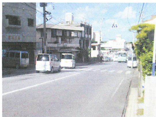
元銘商店前 の市道。都市計画街路としての整備にあたって、信号機の設置を訴えてきたが、全く前進の気配もない
