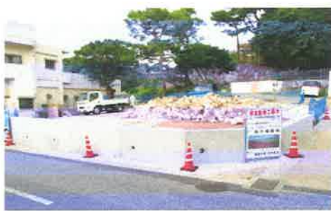
工事が進む上港川緑地公園の元ホテル跡地
