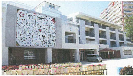
完成した新校舎。左手壁画の下、1階に地域連携室
