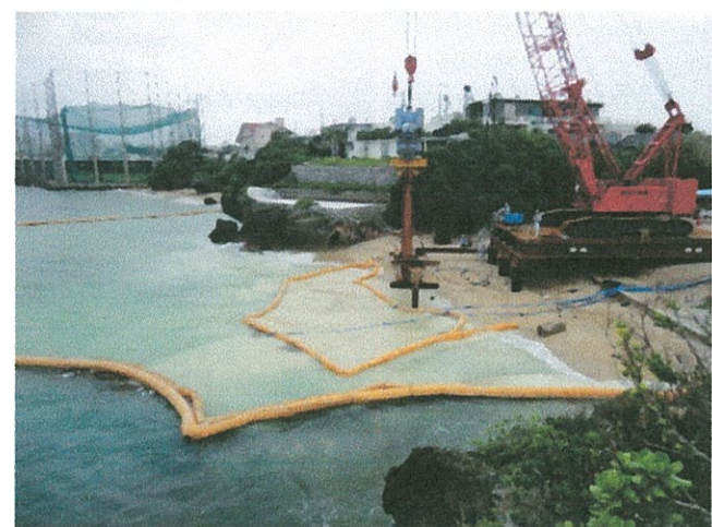
砂浜に鉄骨材を打ち込むカーミージー後方の建設作業(18日撮影)
