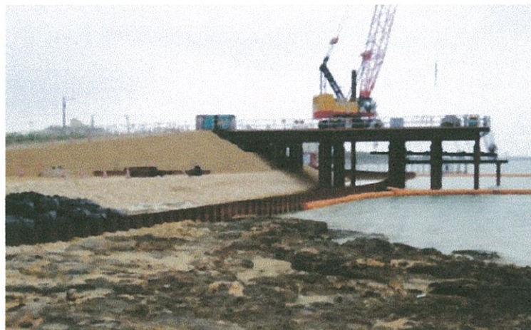
港湾道は基底部の埋立が済み、仮橋建設が進んでいます。対岸も同じような工事が進行中(18日撮影)
