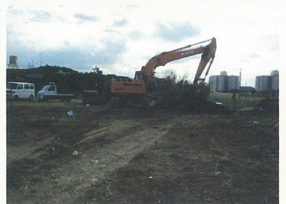
カーミージー後方埋立地で始まった土砂の除去、埋め戻し作業
