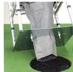
マンホールの上に本体を置き、固定します
