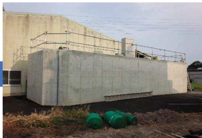
大阪府 クリーニング工場（排水リサイクル）
