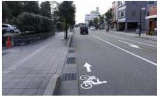
写真 3 車道左側部の車線内にピクトグラムを設置した事例
