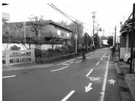
写真Ⅱ-12 自転車、歩行者双方の通行空間を路面表示により明確化した事例
