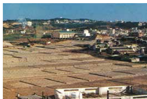
城間伊祖地区土地区画整理事業の様子（昭和55年）
