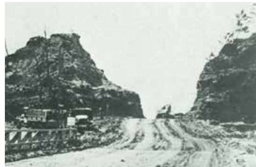
米軍道1号線工事により切り崩された岩山（牧港：昭和20年）
