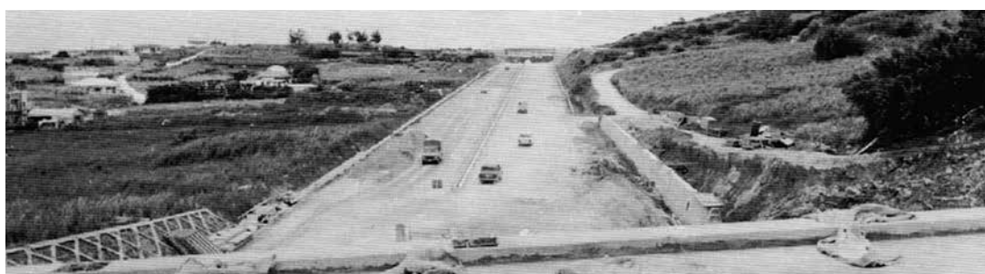
浦添市をほぼ南北に縦断する国道330号の施行中（昭和47年）
