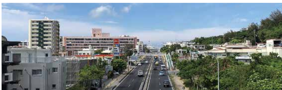
浦添市をほぼ南北に縦断する国道330号の現在の状況（平成30年）
