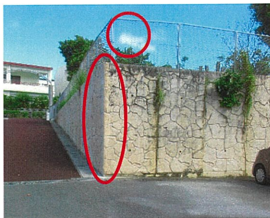
② IVテラス擁壁工事完了(木の伐採と角のひび割れを修理)
