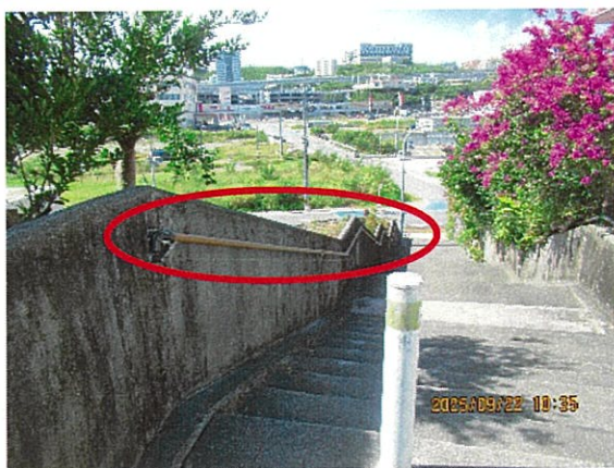
① あじさい公園向いの階段の手すり設置
