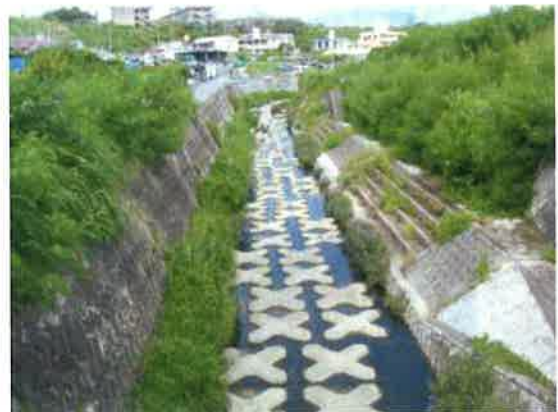
▲河床のブロック
