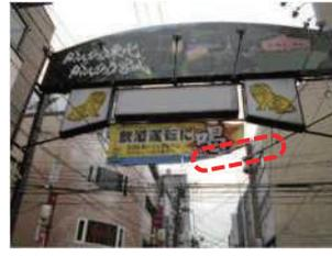
幕材を張る部材が破損した状態
