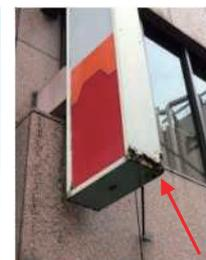
広告板底部の腐食が進行した状態 (左図拡大)
