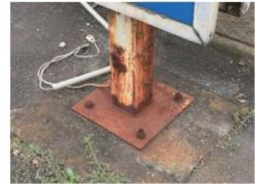
支柱、ベースプレート、アンカー共にさびが顕著な状態
