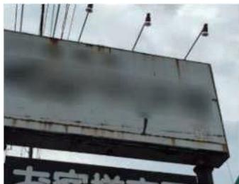
表示面の継ぎ目からさびが垂れた状態
