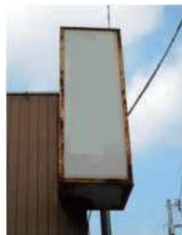
表示面板押さえのさびが進行した状態 (左図拡大)
