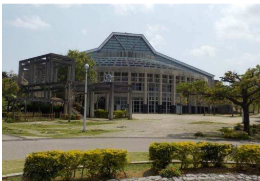
既存市民体育館の外観
