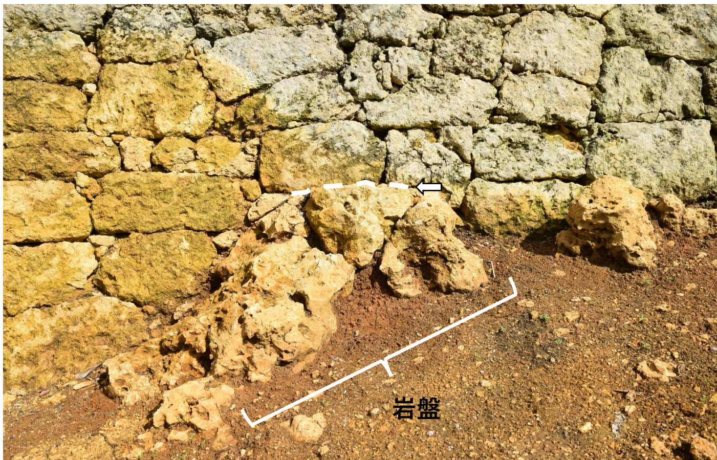
⑤平らに削られた岩盤（点線・矢印）
