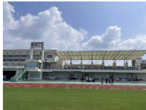
メインスタンド (金武町陸上競技場)
