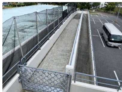
車いす用スロープ （金武町陸上競技場）
