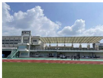
メインスタンド （金武町陸上競技場）
