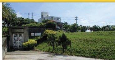
耐震補強工事を実施済
