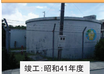
仲間配水池 仲間増圧ポンプ所
