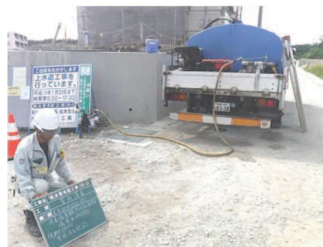
水運搬・貯水タンクへの ポンプ圧送の状況
