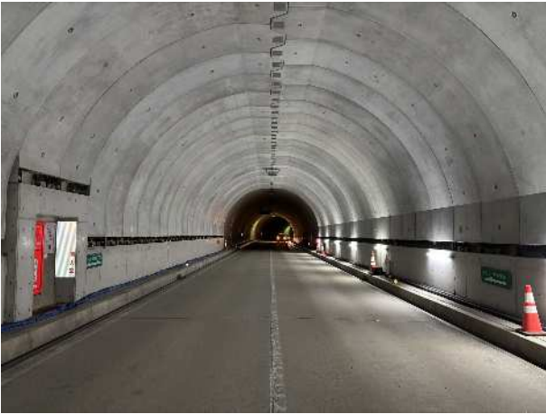
写真 7-1. PCL 工法（設置イメージ）
