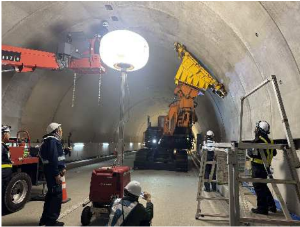
写真 7-2. PCL 工法（施工状況）
