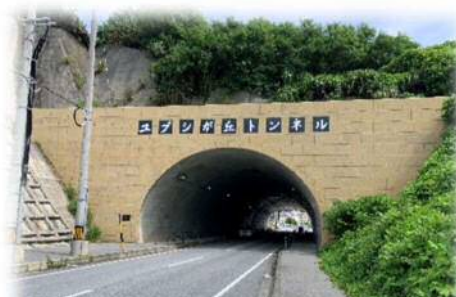
ユブシが丘トンネル 起点側
