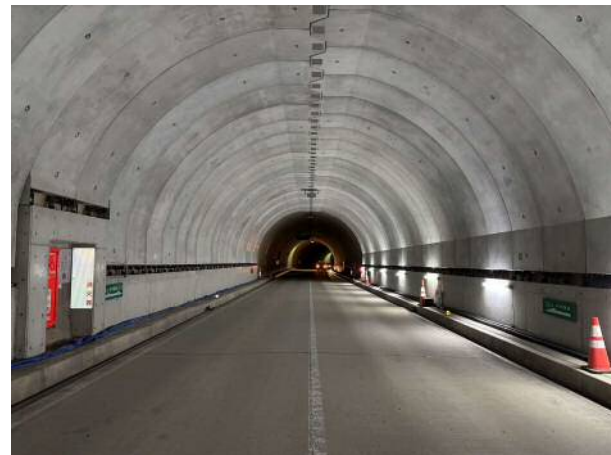
写真 7-1. PCL 工法（設置イメージ）
