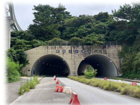
写真 2-1. 前田トンネル
