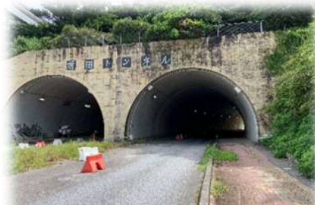
前田トンネル（上り線）起点側
