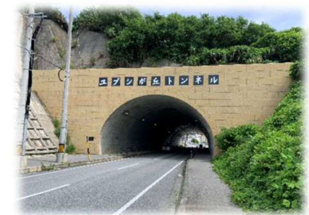
写真 2-2. ユブシが丘トンネル
