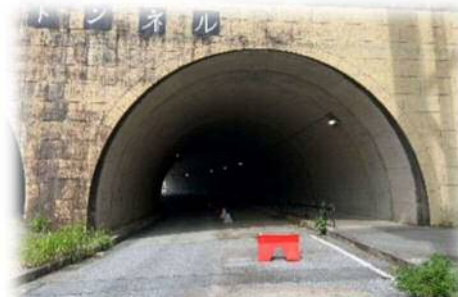
前田トンネル（下り線）終点側
