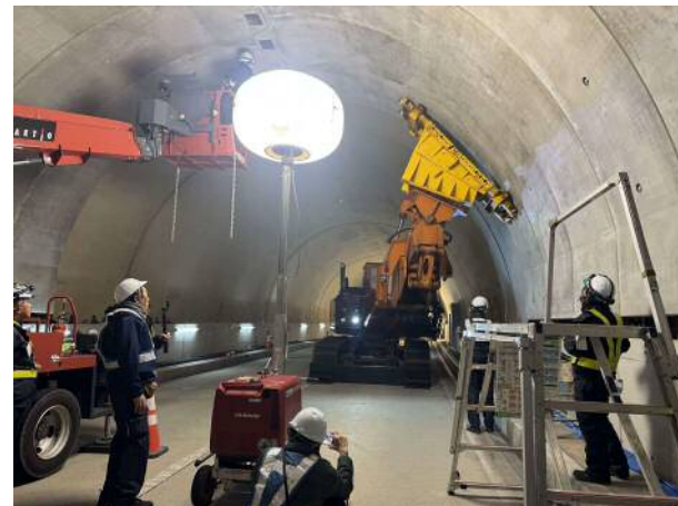
写真 7-2. PCL 工法（施工状況）
