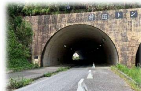
前田トンネル（上り線）終点側
