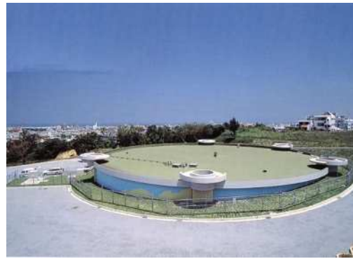
2. 沢岬配水池 (容量11,000m 3 )
