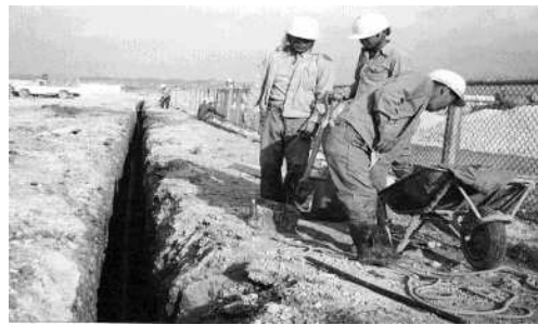
手作業による配水管布設工事
