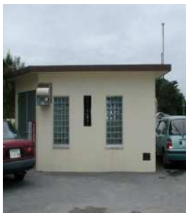
5. 前田増圧ポンプ室
