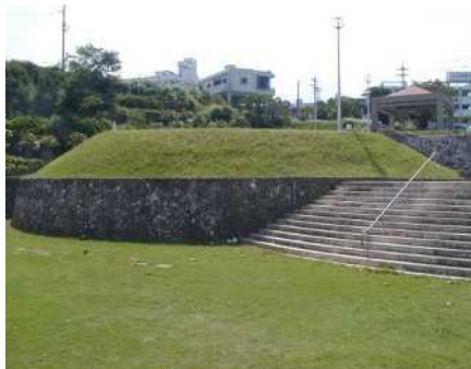
3. 浦仲配水池 (容量5,000m 3 )
