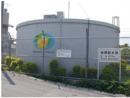
1. 仲間配水池 (容量273m 3 )
