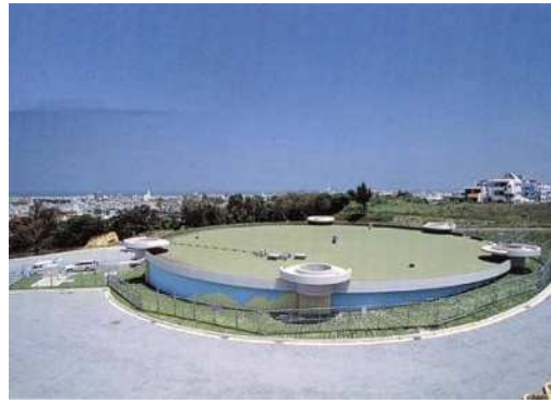
2. 沢岬配水池 (容量11,000m 3 )
