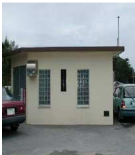
5. 前田増圧ポンプ室
