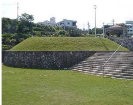
3. 浦仲配水池 (容量5,000m 3 )
