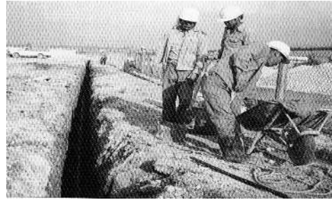
手作業による配水管布設工
