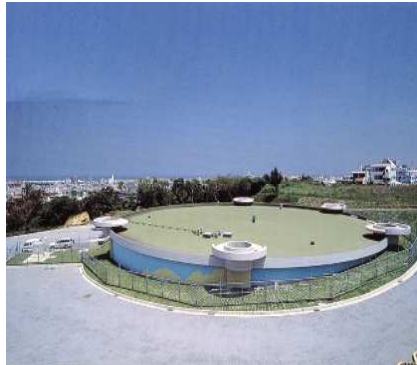
2. 沢岬配水池 (容量11,000m 3 )
