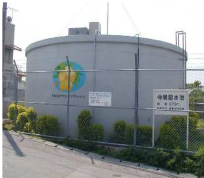
1. 仲間配水池 (容量273m 3 )
