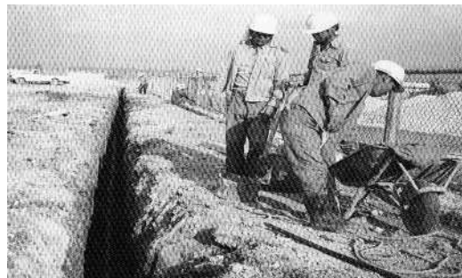
手作業による配水管布設
