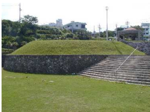
3. 浦仲配水池(容量5,000m 3 )
