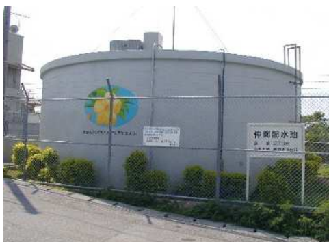
1. 仲間配水池（容量273m 3 ）
