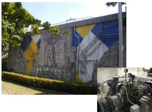
4. 浦仲中継ポンプ施設
