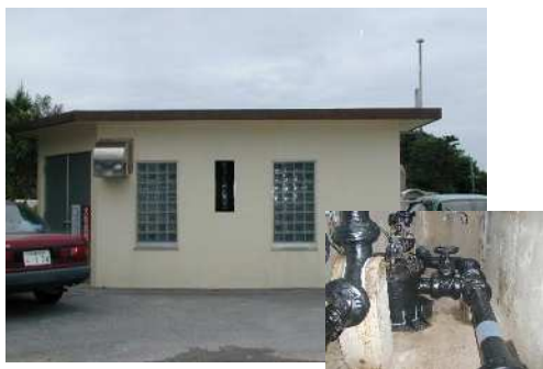
5. 前田増圧ポンプ施設
