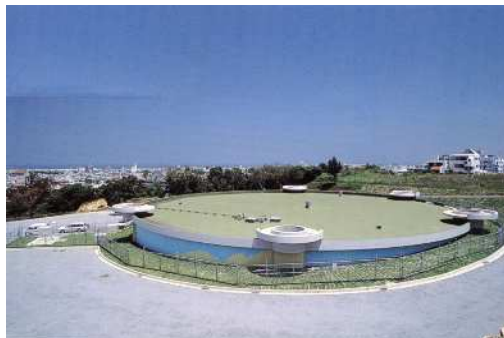
2. 沢岬配水池(容量11,000m 3 )
