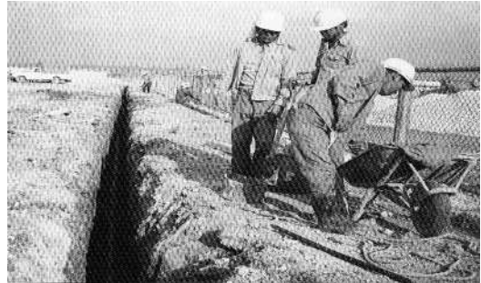
手作業による配水管布設
