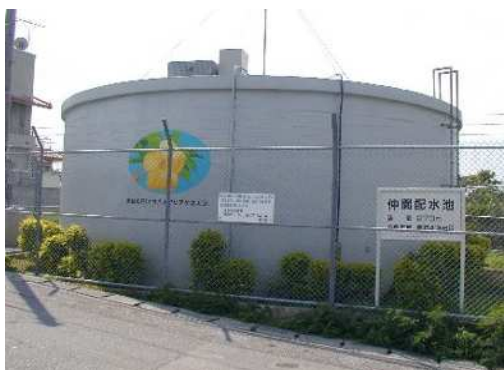
1. 仲間配水池 (容量273m 3 )
