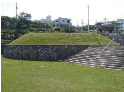
3. 浦仲配水池 (容量5,000m 3 )
