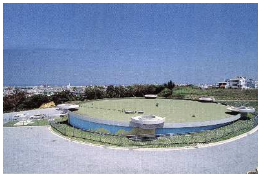
2. 沢岬配水池 (容量11,000m 3 )
