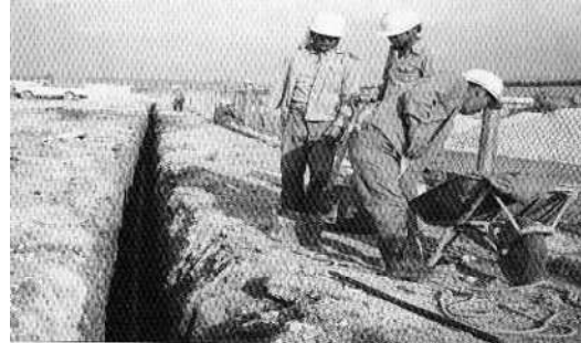
手作業による配水管布設
