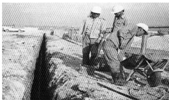
手作業による配水管布設
