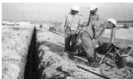
手作業による配水管布設工事
