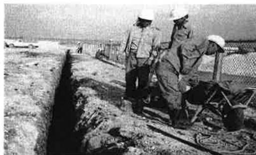
手作業による配水管布設工事
