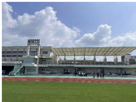
メインスタンド (金武町陸上競技場)
